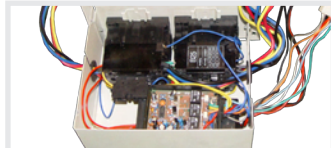
Startautomatik (ATS-Einheit) Mikroprozessor gesteuerte Startautomatik bei Ausfall der Netzspannung.
